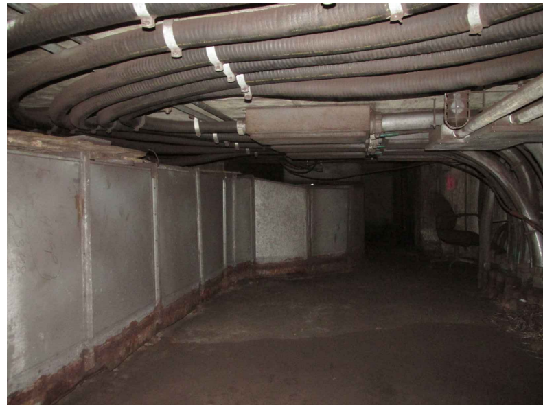
2 EXISTING CONDITION UNDER PLATFORM SCALE: N.T.S.
